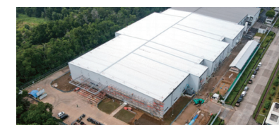
建設中のインドネシア・カラワン工場第2棟
