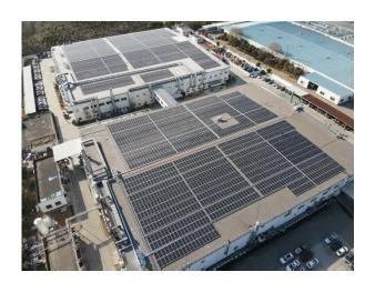
Symbior Solar 负责该项目的投资、设计、工程建设和全生命周期运营维护,确保光伏发电系统产生的绿色可再生电能将在未来 25 年持续供给希革斯电子(上海)。
