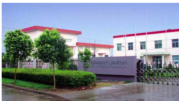
Takaya SIIX EMS (Shanghai) Co., Ltd.の新工場
